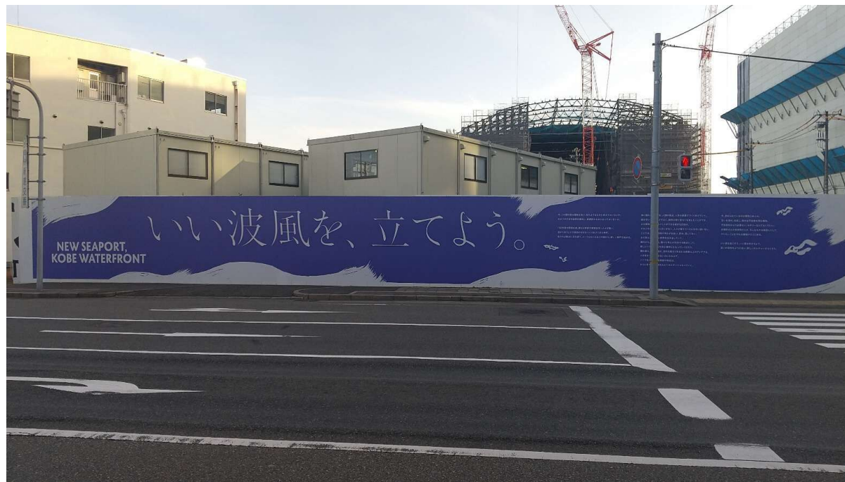
(工事中の万能塀の活用)
