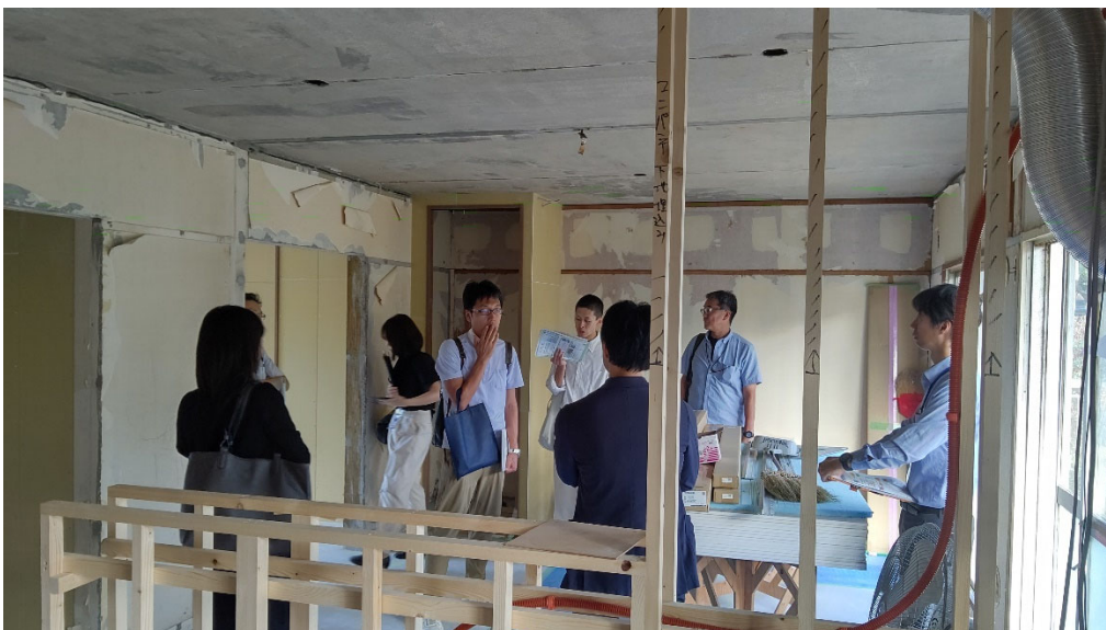
改修中のコミュニティスペース
