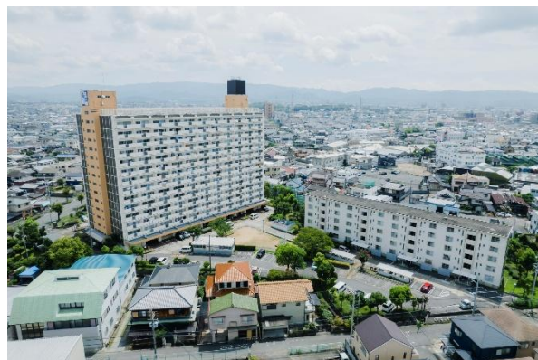
改修後のさのみなと団地
