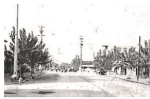
図-2 疎開道路の様子 東成区(1957)「東成区史」,図録より
