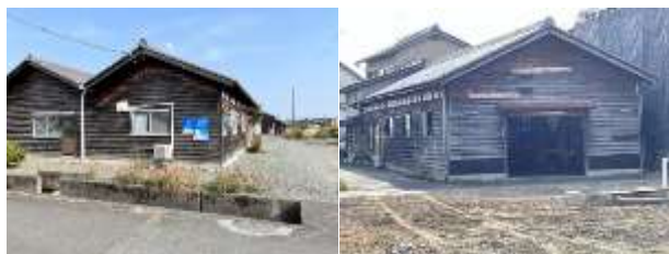
【写真－1】木造の繊維工場・外観 (2)
