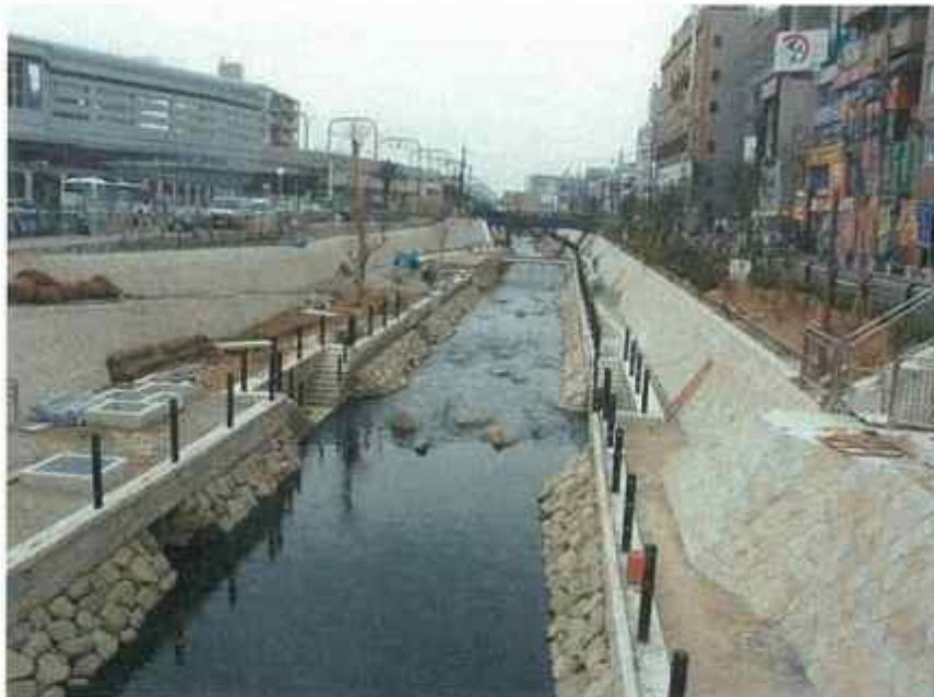
工事中の親水空間の状況
