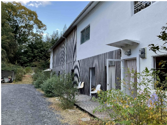
リノベーションされた住宅と駐車場
